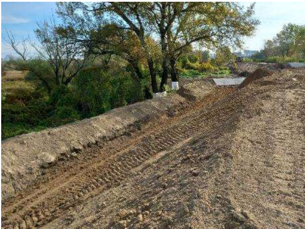
Foto. 10. Wał prawy, km ok. 0+500 – osłony pojedynczych, grubopniennych drzew za pomocą odeskowania (3. dekada października 2021 r.).
