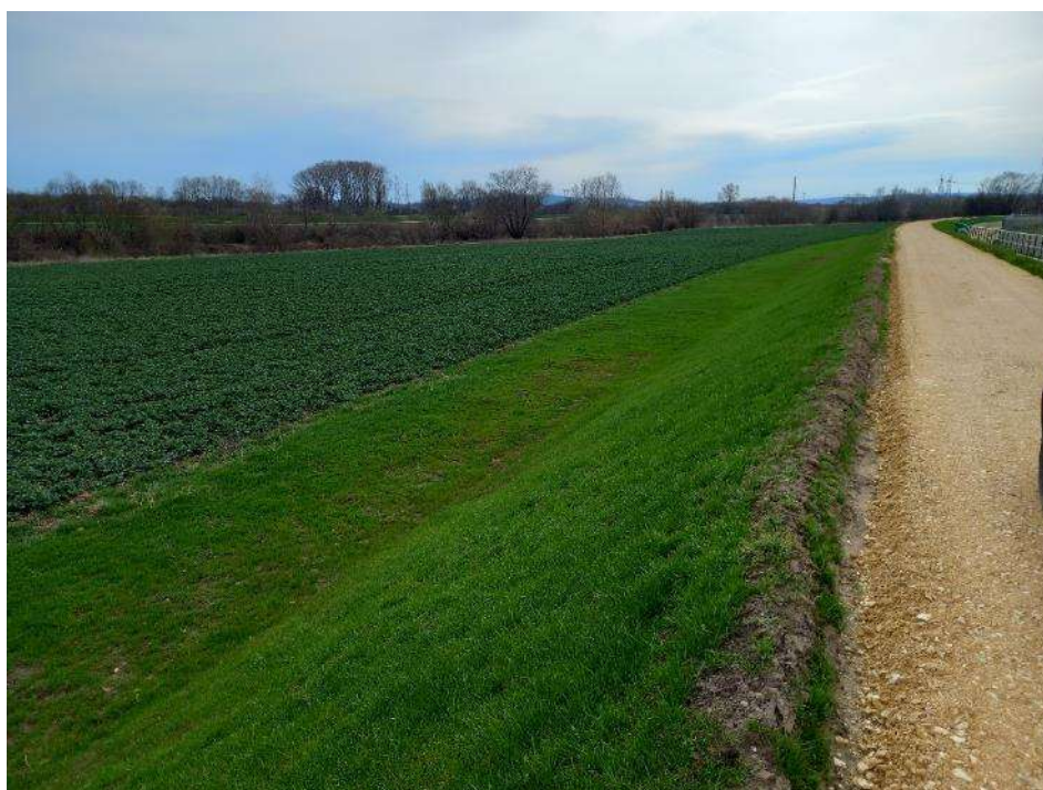
Foto. 17. Wał lewy, km ok. 1+300 – porost traw po wykonaniu humusowania i rekultywacji wału (3. dekada marca 2023 r.).
