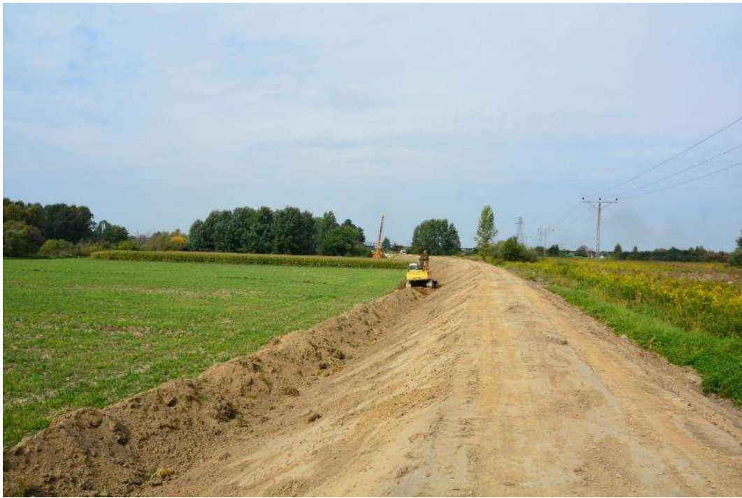
Foto. 9. Wał prawy, km ok. 1+200 – odhumusowanie wału (wrzesień 2021 r.).
