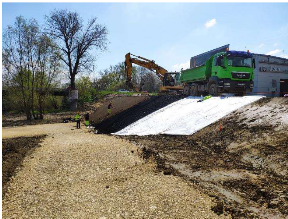
Foto. 20. Wał lewy, km ok. 6+000 – humusowanie i rekultywacja terenu (2. dekada kwietnia 2023 r.).
