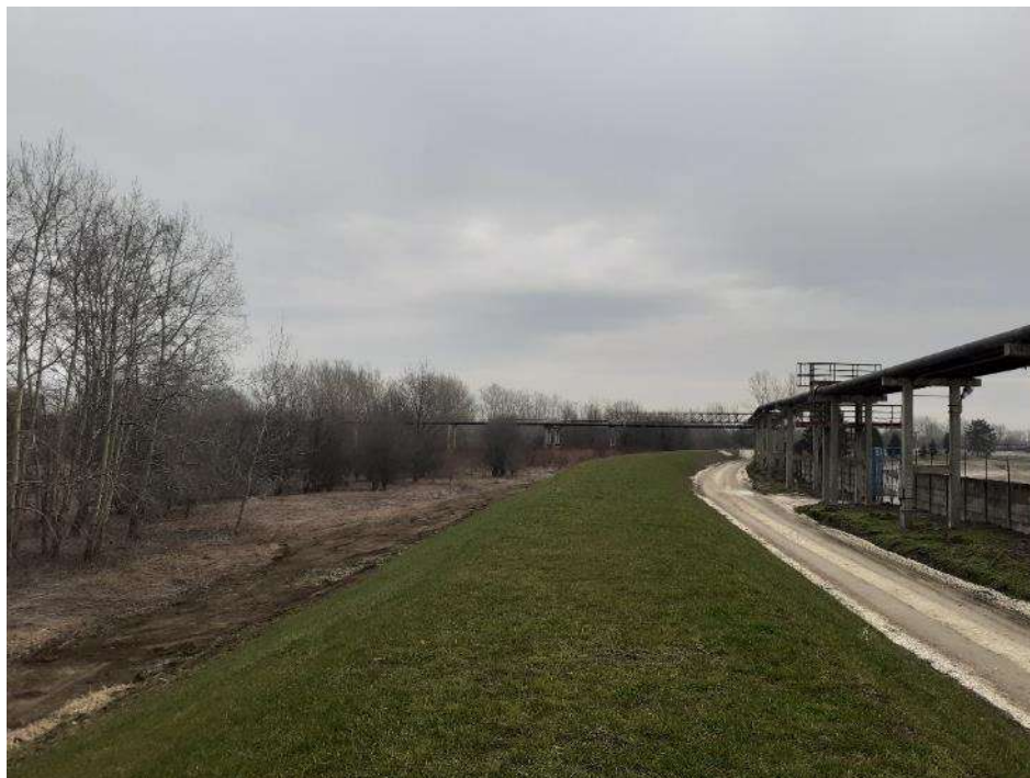
Foto. 15. Wał lewy, km ok. 0+600 – porost traw po wykonaniu humusowania i rekultywacji wału (2. dekada lutego 2023 r.).
